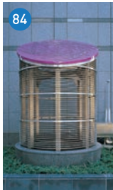
84 □江上計太 日本 1951- Keita Egami Japan 1951- 換気塔 ventilation tower
