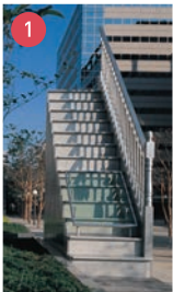
1 □リチャード・ウィルソン イギリス 1953- Richard Wilson UK 1953- 共同溝入口、排気口 entrance to the utility tunnel, vent
